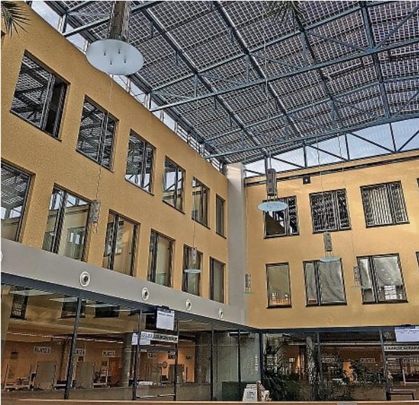
Das neue Atriumdach mit den neuen Lüftungsauslässen
